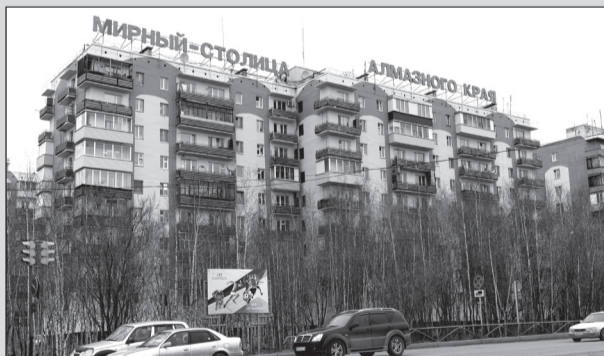
Кроме покраски фасадов подрядчики выполнили утепление и герметизацию межпанельных швов
